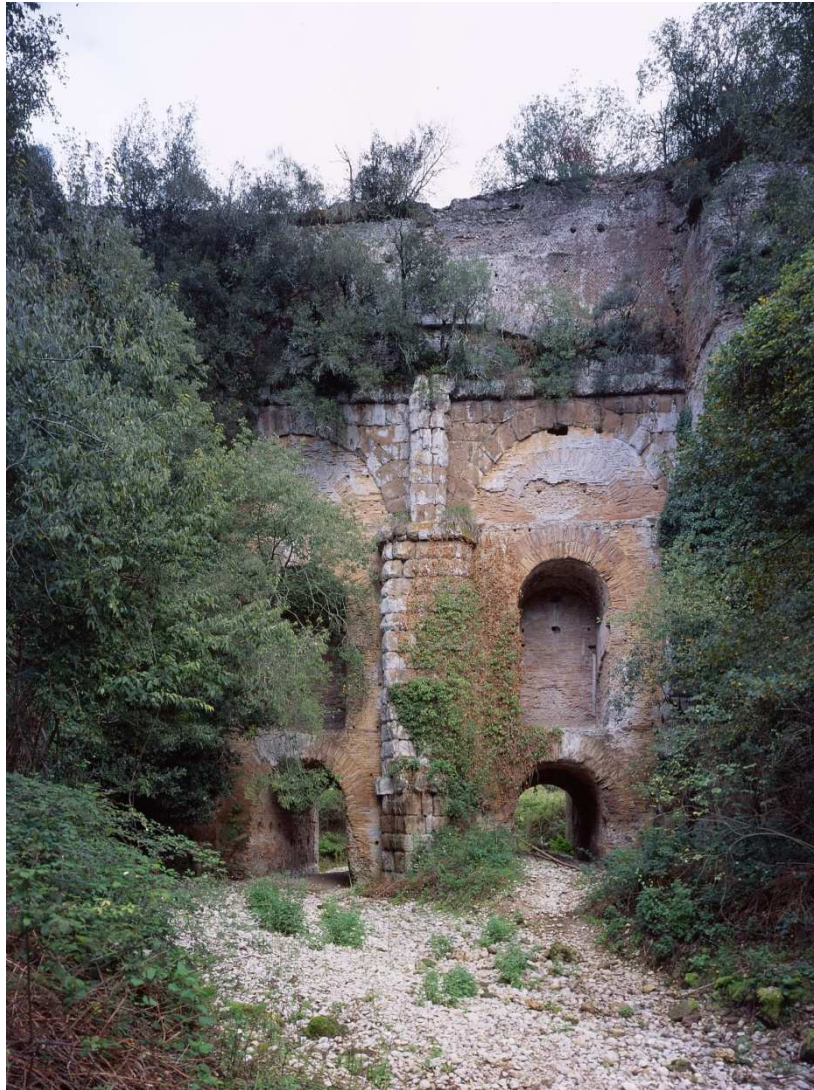
Ponte Lupo – (Acqua Marcia)
