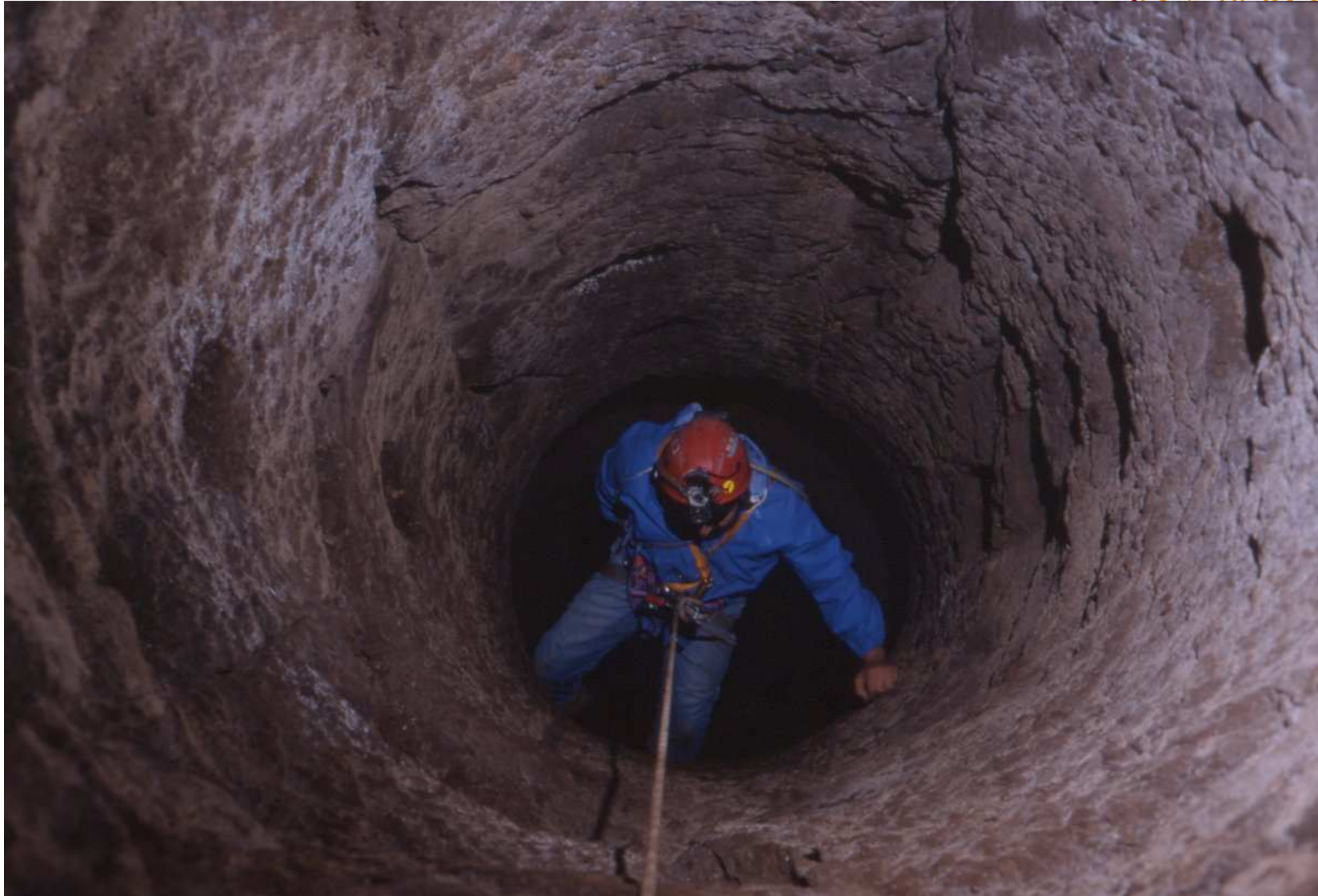
Ispezione alla galleria della Bulica – (Acqua Marcia)
