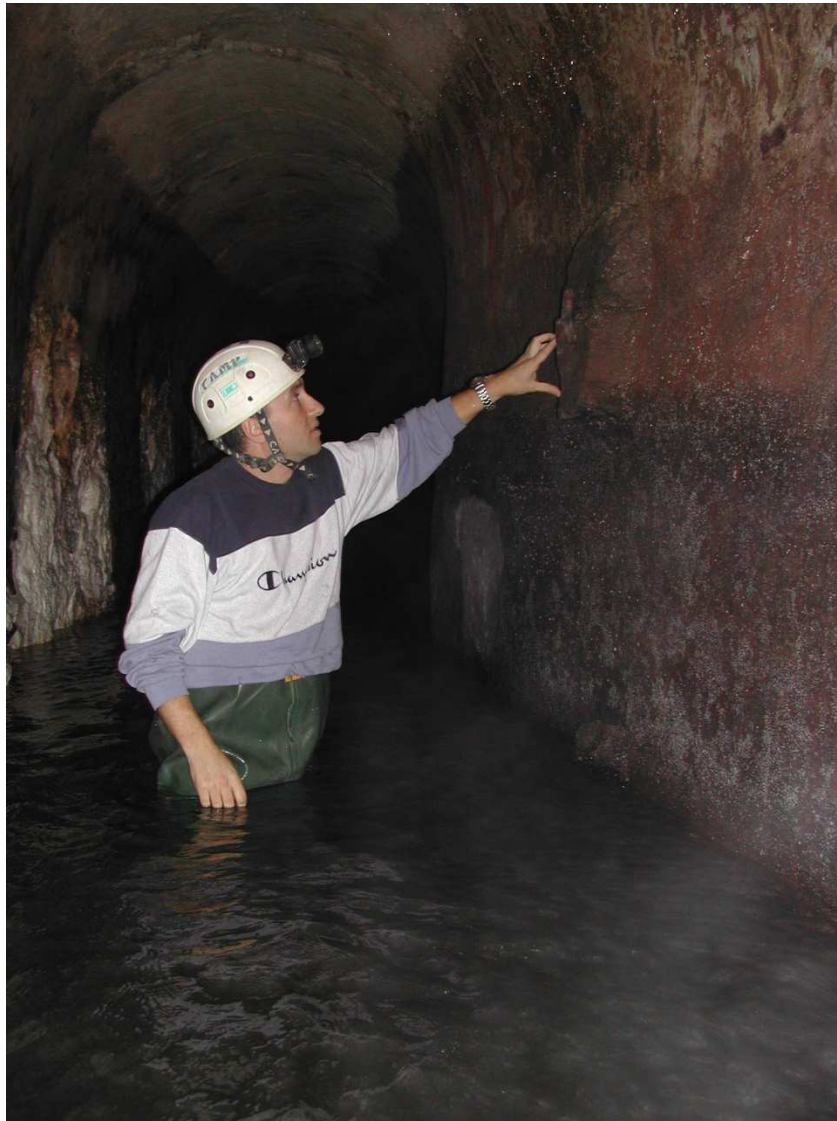
Malta idraulica – (Acqua Virgo)
