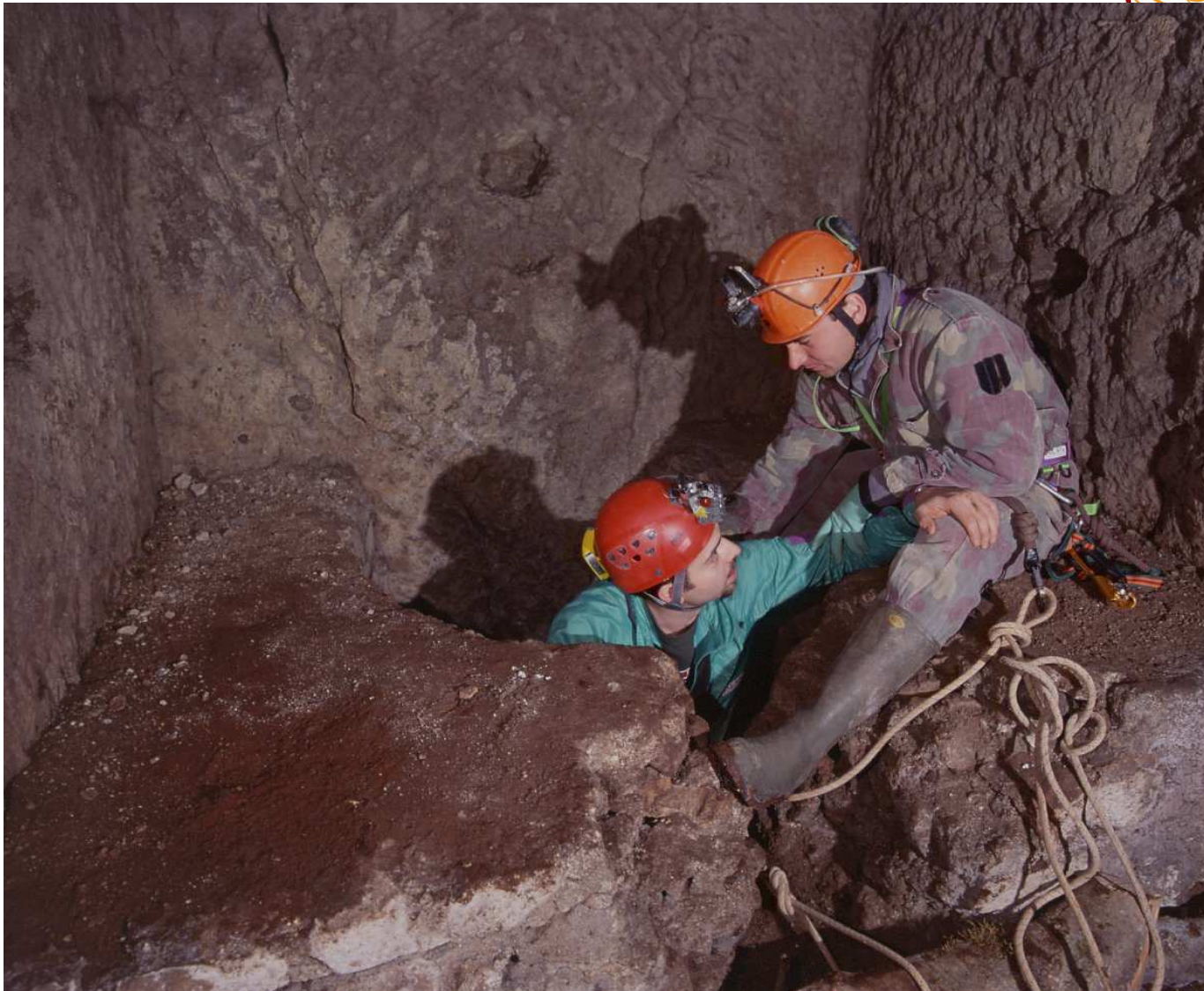
Ispezione alla galleria della Bulica – (Acqua Marcia)
