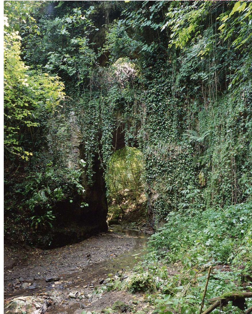
Ponte Caipoli – (Acqua Marcia)
